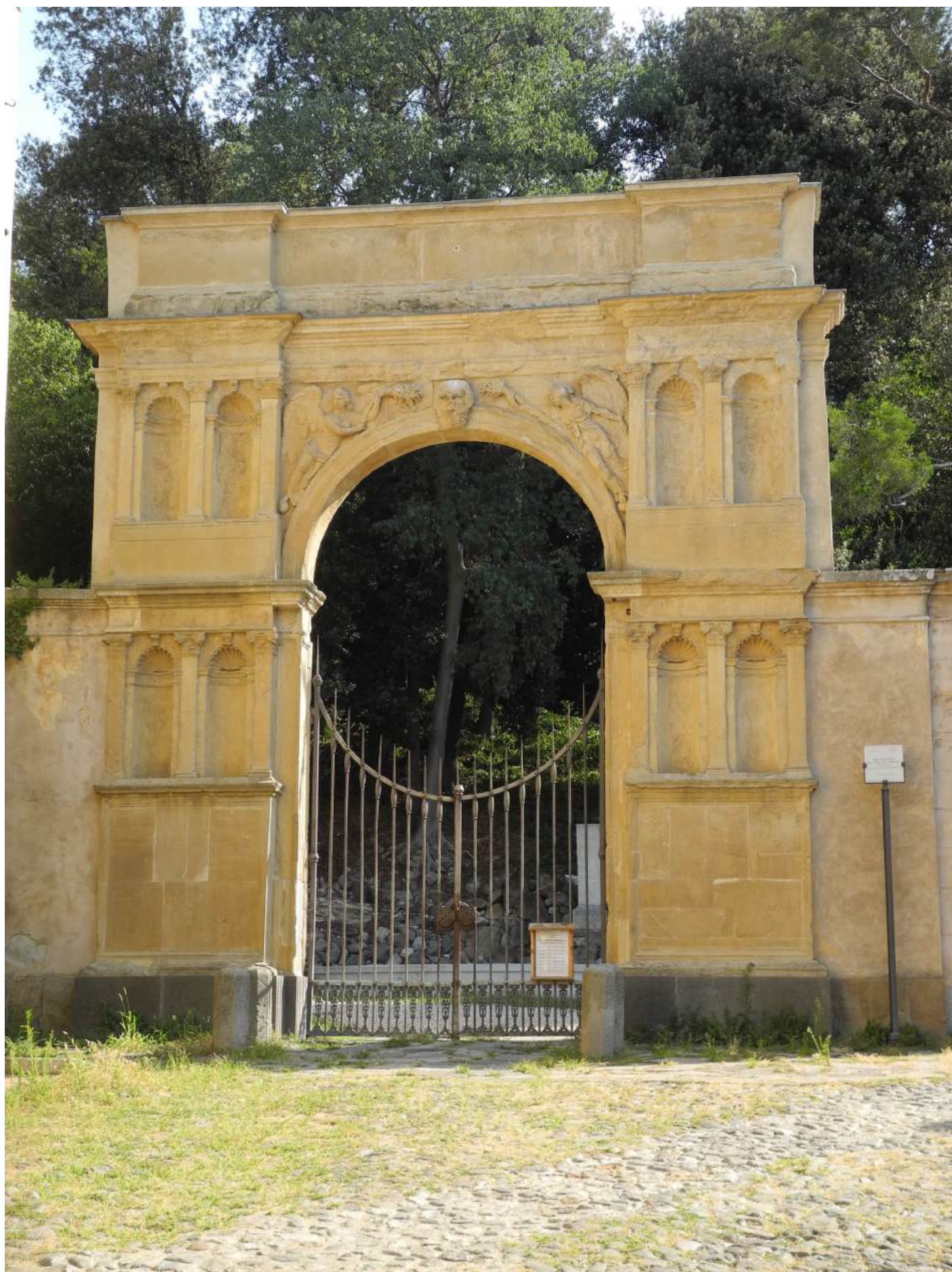
Arco d'ingresso al giardino di Alvise Cornaro ad Este, attribuito al Falconetto. XVI secolo.
