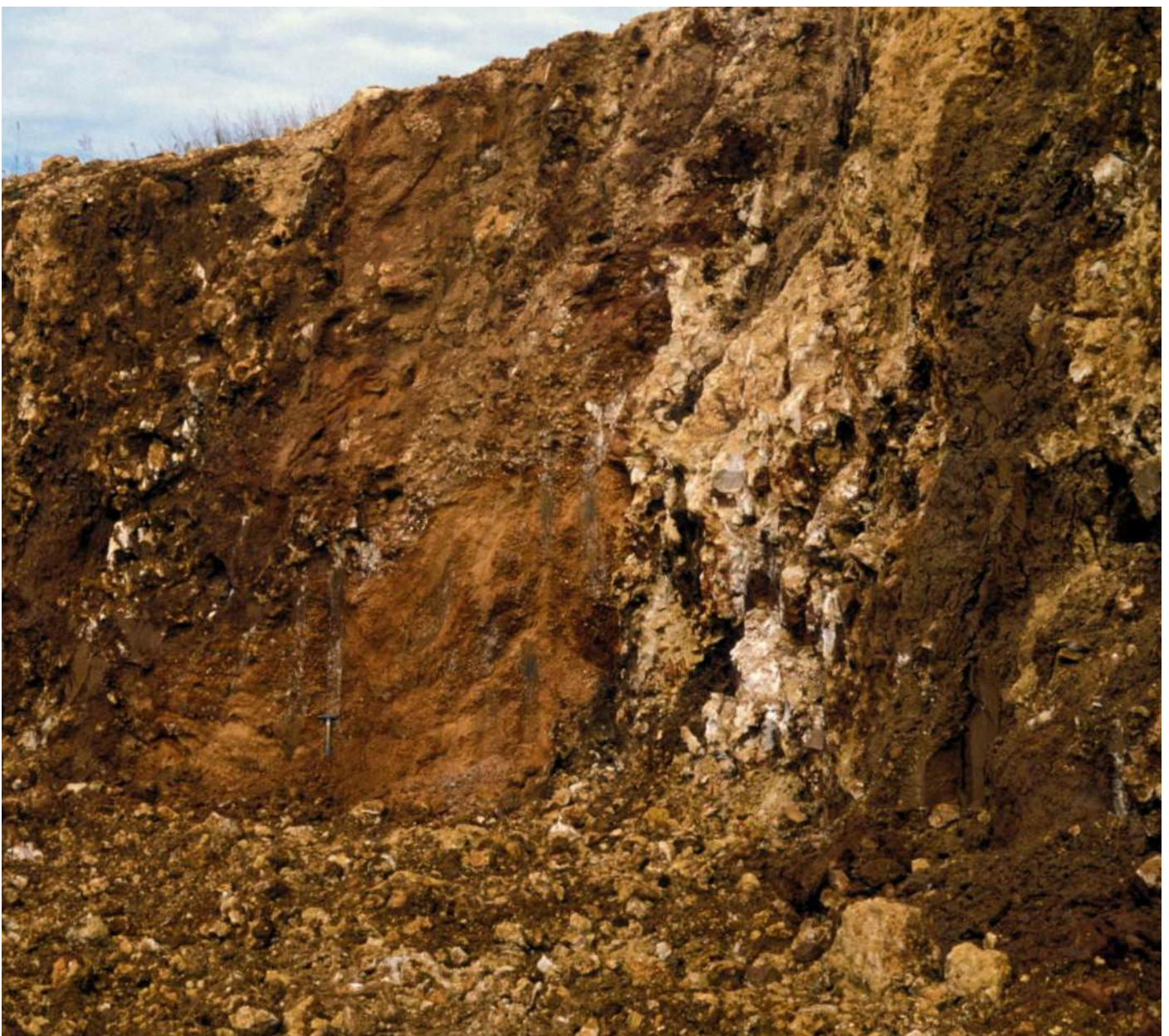
Grande cavità carsica intercettata dai lavori di scavo nell'unità n. 4 a metà degli anni '90. La cavità risultava riempita da argilla rossa con livelli di sabbie e ghiaie.
