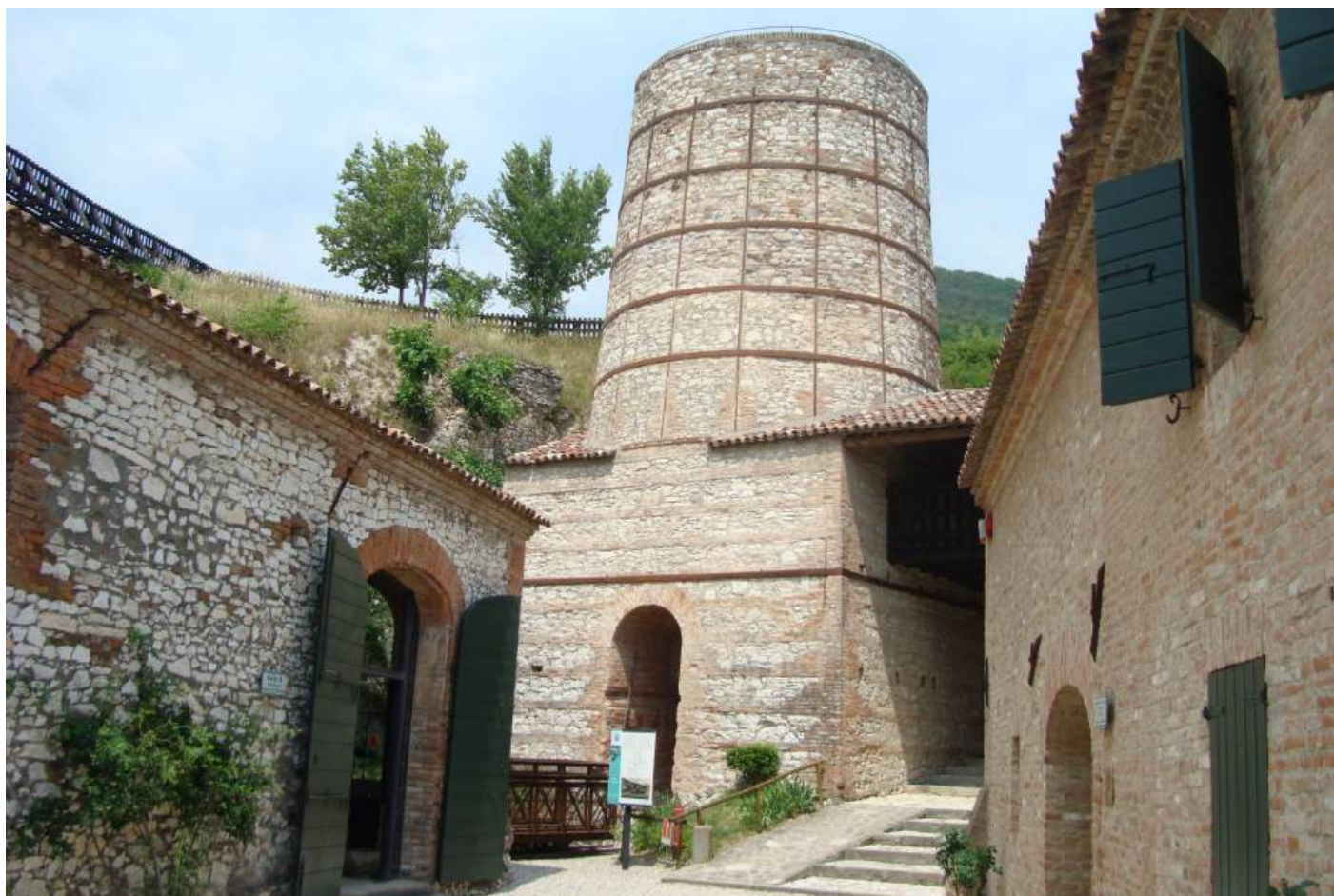
Fig. 165 Forno a tino del complesso industriale per la produzione di calce Cava Bomba a Cinto Euganeo. La fornace Bomba, di impianto ottocentesco, è stata ampliata nel primo novecento ed è stata in funzione fino agli anni 50. L'antico complesso industriale, in seguito ad un attento restauro, è stato adibito a Museo Geopaleontologico e Archeoindustriale.
