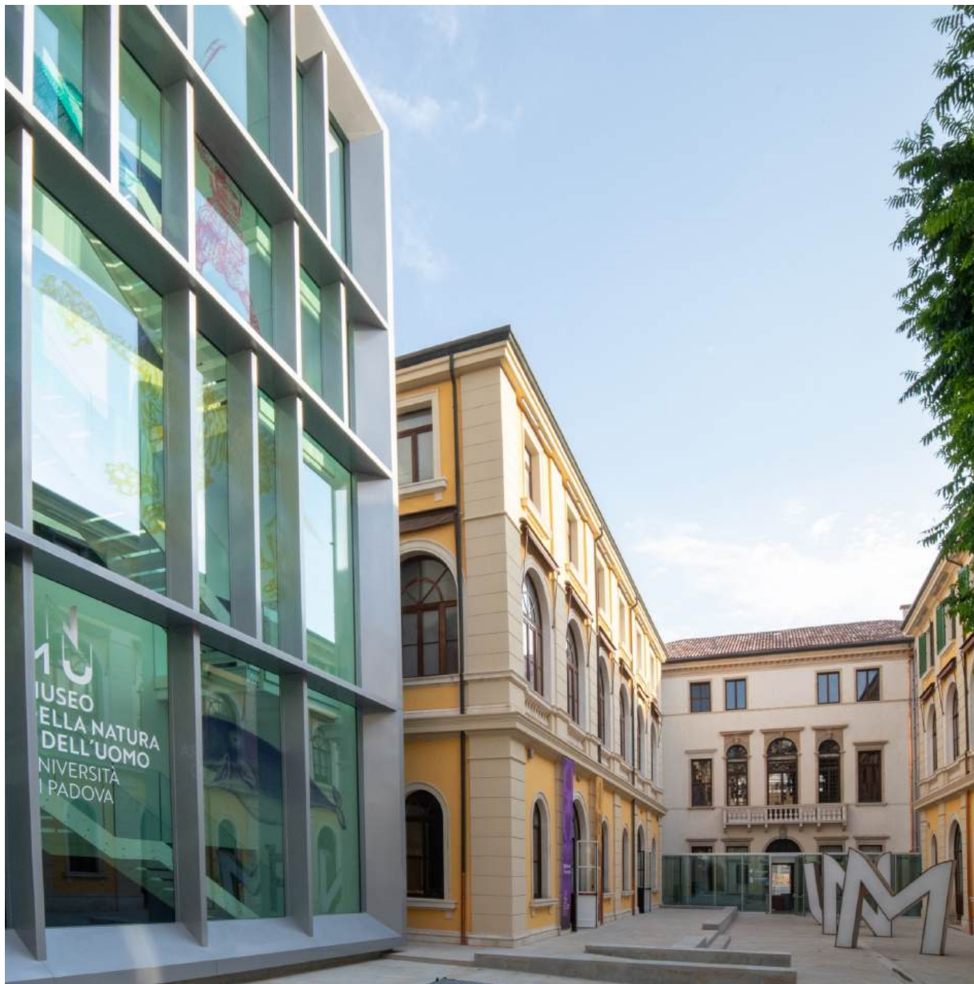
Fig. 01 Veduta d'insieme del complesso museale MNU che comprende il cortile interno dello storico Palazzo Cavalli e la modernissima struttura in vetro e acciaio, completata nel 2023. Foto F. Milanesi.
