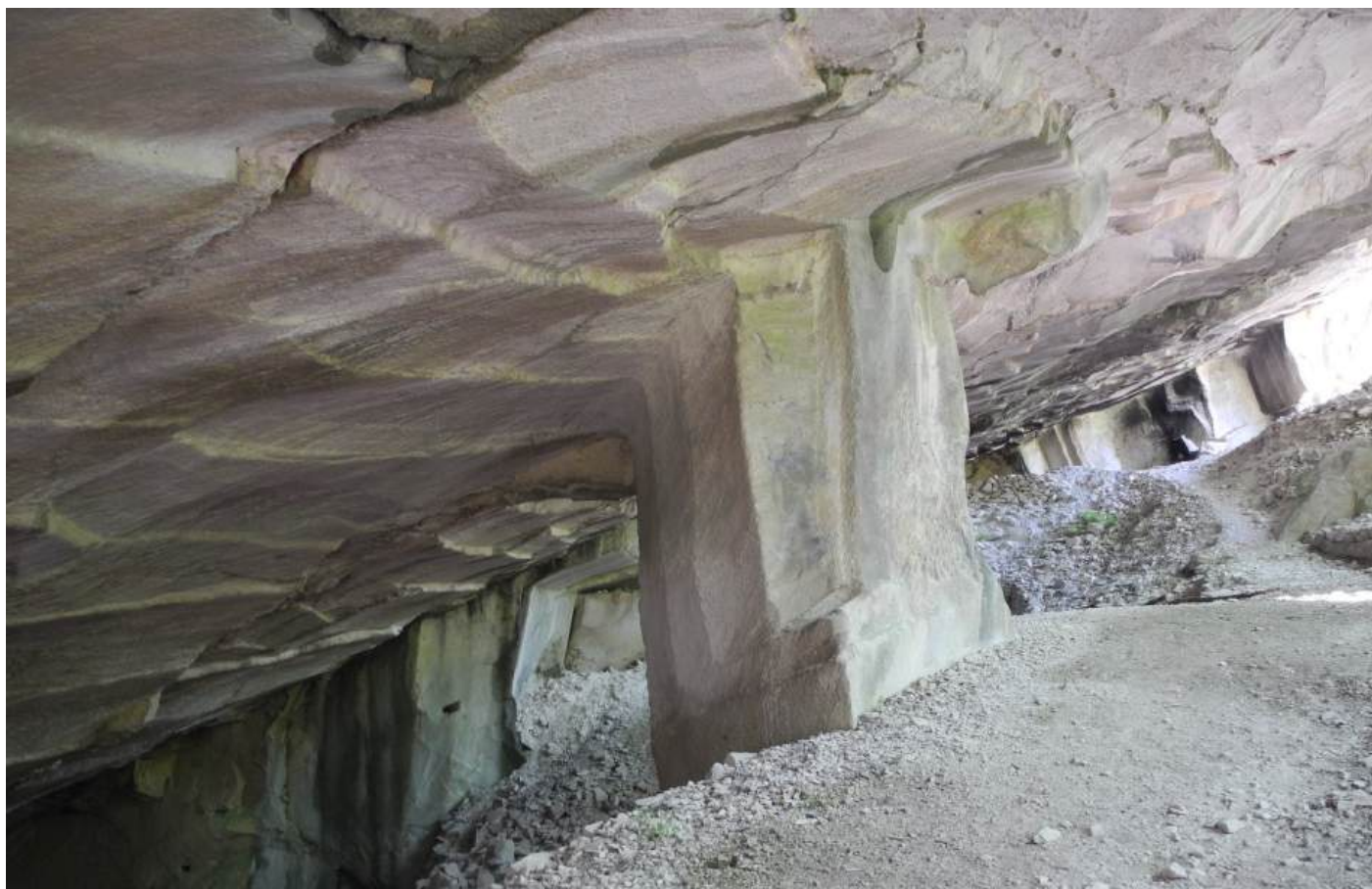
Fig. 4.4 Cava in galleria della pietra statuaria di Massone. I pilastri venivano conservati per sorreggere il tetto della galleria.
