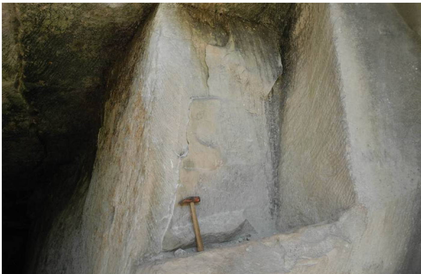
Fig. 4.5 Cave di pietra statuaria di Massone, particolare di superfici di taglio a scalpello.
