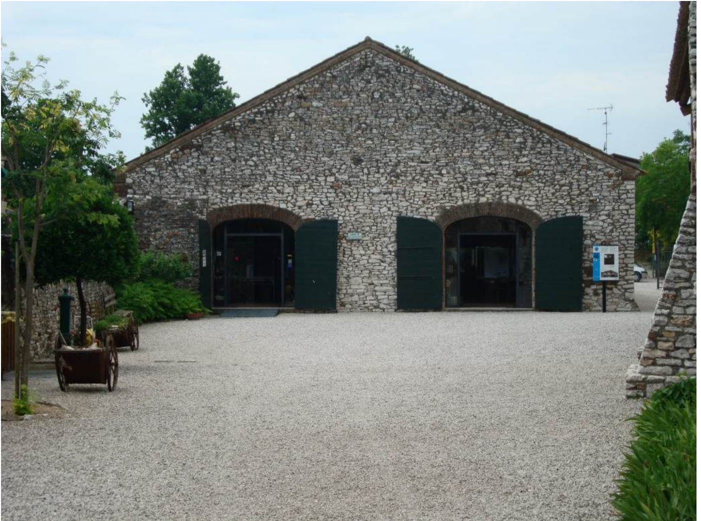
Fig. 17 L'edificio della sala A; originariamente era un magazzino.
