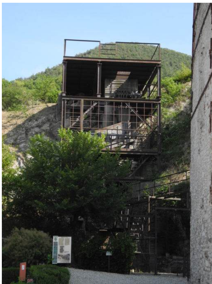
Fig. 15 Il frantoio installato alla fine degli anni '60 per frantumare la roccia calcarea, usata per alimentare i forni del cementificio di Este.
