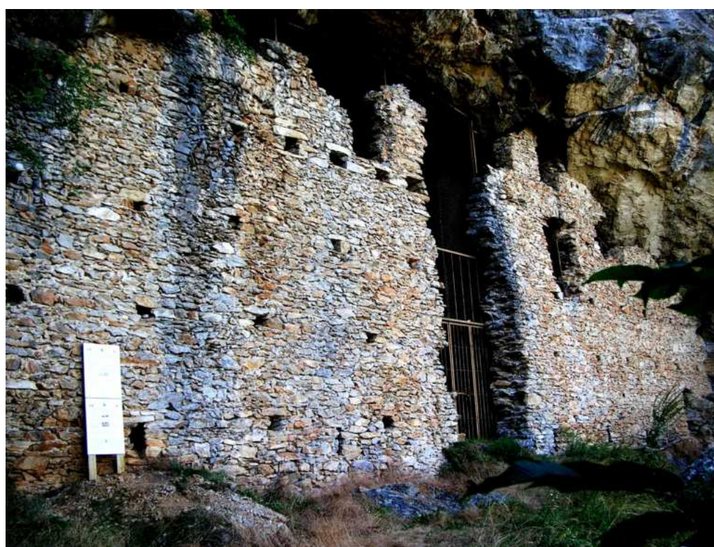
Fig. 9 Grotta dei Saraceni o Balma del Messere (950 m) nella zona di borgata Cantarana di Ormea, una caverna asciutta di circa 200 mq con un muro incredibile che ne protegge l'uscita. All'interno esistevano 2 piani: la struttura ha caratteristiche di abitazione (finestre e porte) ma anche di fortezza (finestre strombate).
