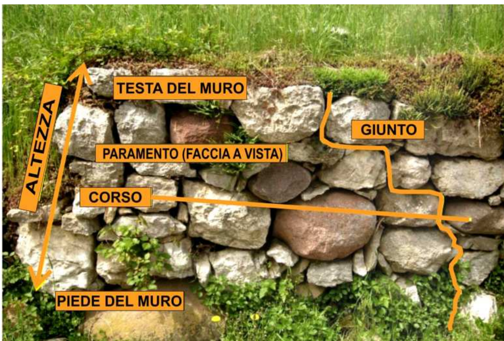
Fig. 1 Fronte della struttura di un muro in pietre a secco.
