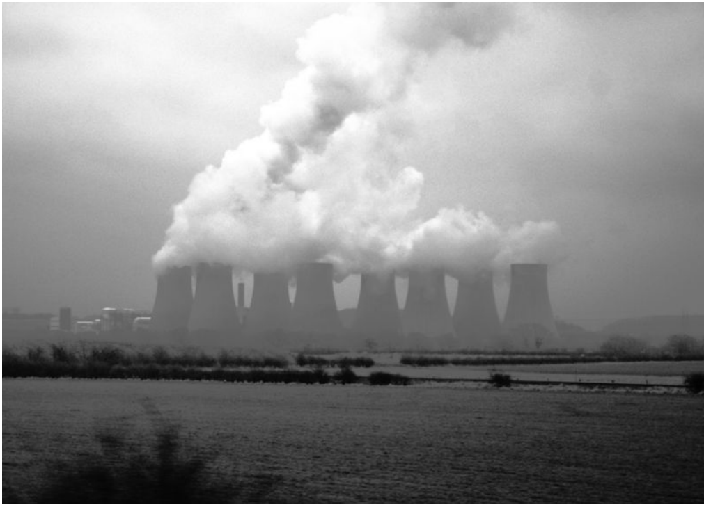
fig. 25 - Oggi il carbone è usato soprattutto nelle centrali termoelettriche per produrre energia e in piccola parte, nei forni delle acciaierie.
